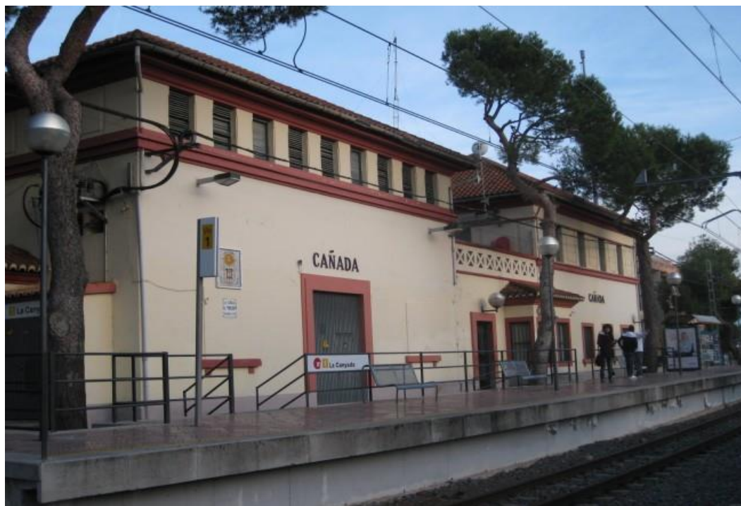
Parada de metro de la Canyada de la línia 2
